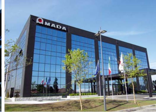
Technical Center in Italien
